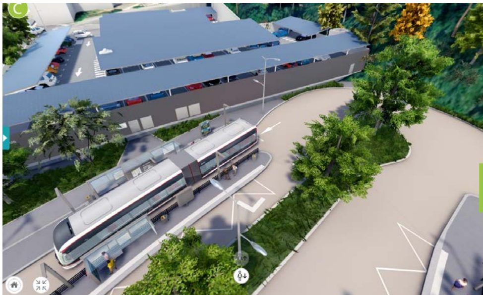
Le futur terminus de la ligne C à Durtol, avec aire de retournement pour le tram-bus et parking-relais pour les voitures.
