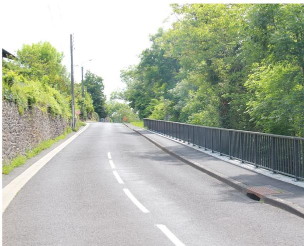
Rue de Blanzat, à la sortie de Sayat, des travaux ont été réalisés par le Conseil Départemental du Puy-de-Dôme afin de rehausser et consolider les ouvrages soutenant cette route départementale. Une main courante a également été installée sur les deux ouvrages : une opération prise en charge intégralement par le Département.
