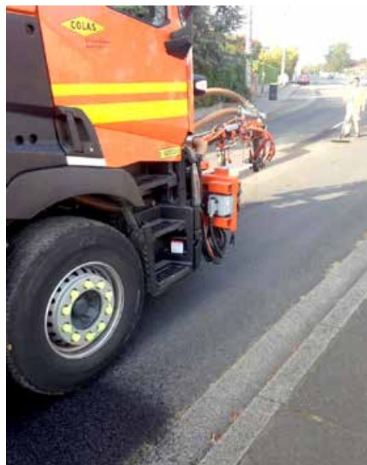
Réfection des nids de poule par Blowpatcher
