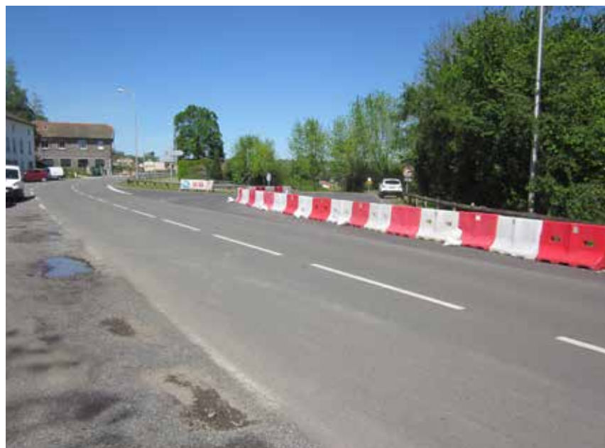
Test d'aménagements de sécurité au carrefour Route du Cratère / Avenue de Clermont
