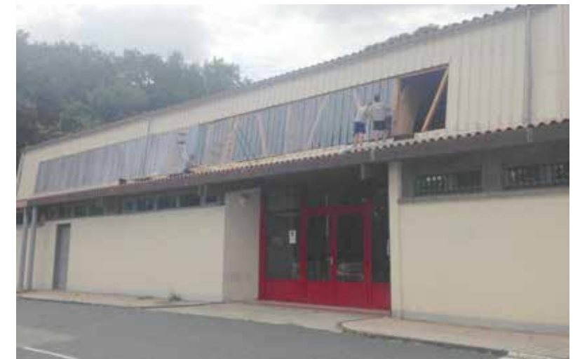
Pose des translucides
